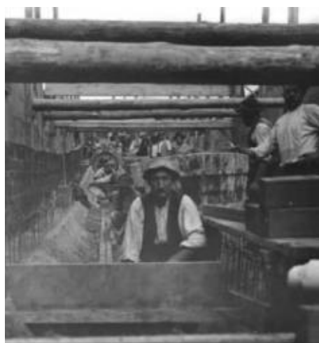
Polnische Arbeiter beim Bau des Mittellandkanals
